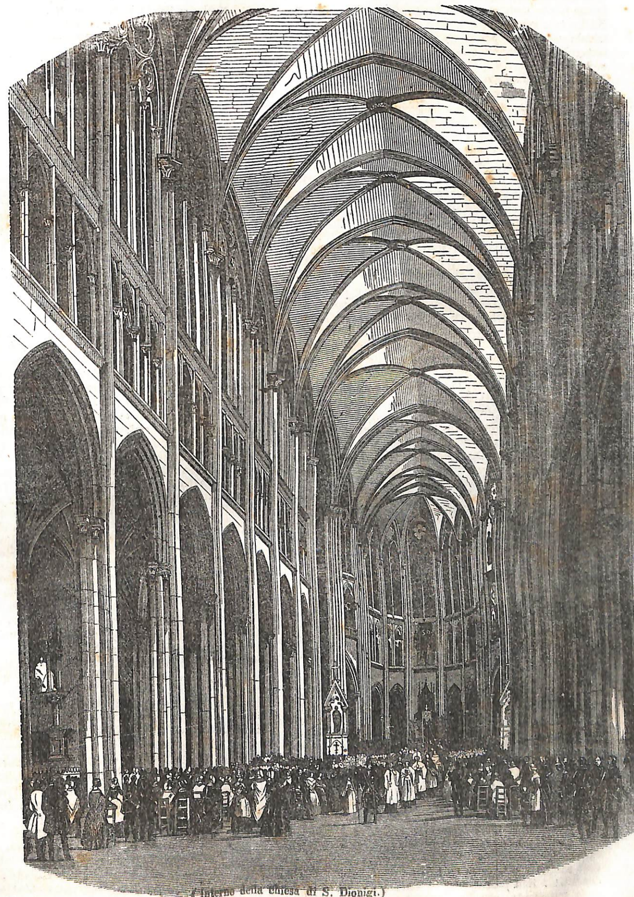
(Interno della chiesa di S. Dionigi.)
